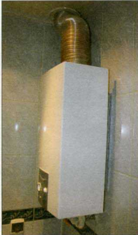
Tlenek węgla może okazać się niebezpieczny w łazienkach wyposażonych w piecyki gazowe.
