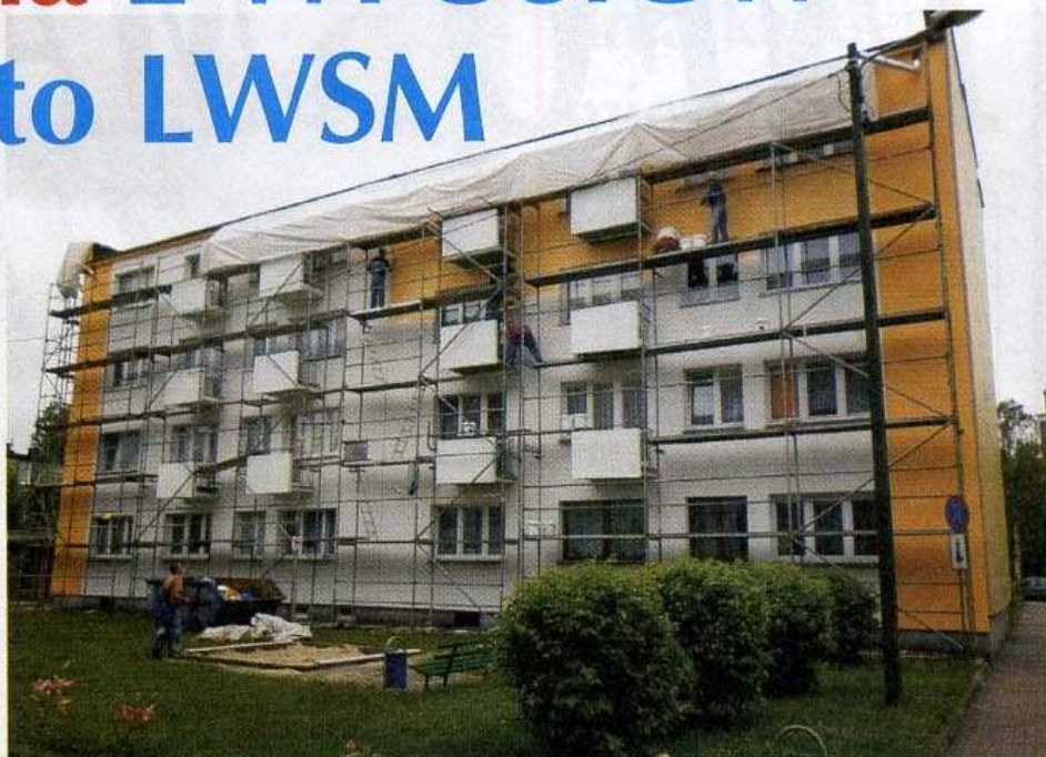
Prace przy odnowieniu elewacji budynku przy ulicy Spółdzielczej 12.
