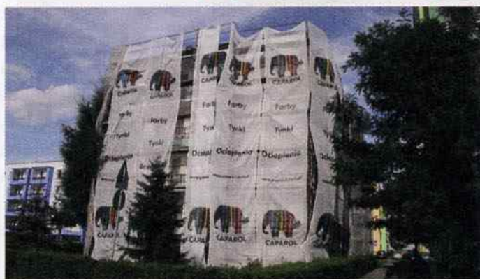
Przy ulicy Piłsudczyków trwa remont elewacji
