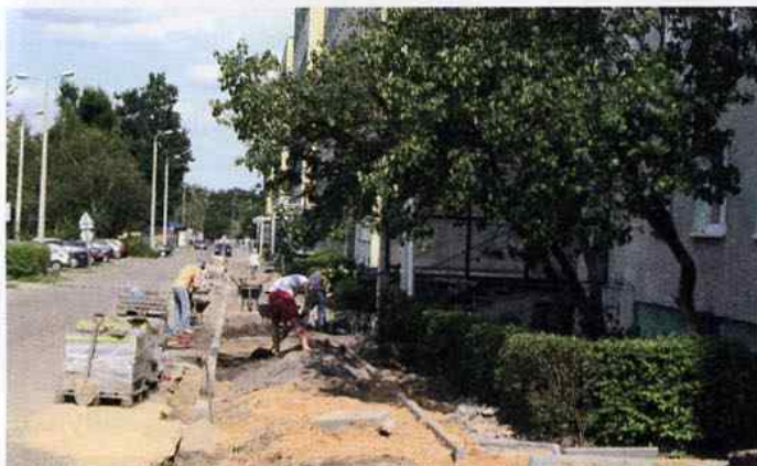
W Szczygłowicach trwają prace przy budowie nowego chodnika w sąsiedztwie wieżowców przy Alei Piastów
