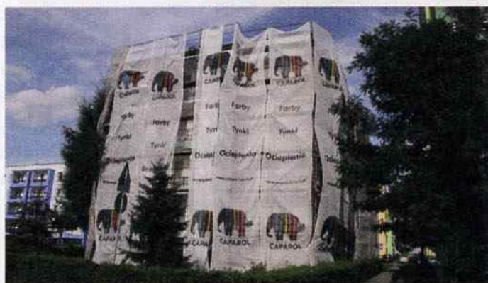
Przy ulicy Piłsudczyków trwa remont elewacji
